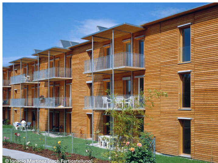
© Ignacio Martinez (nach Fertigstellung)
